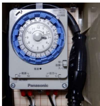
コンセントタイマー例(写真-1) 浄化槽ブロワ間欠運転ユニット
